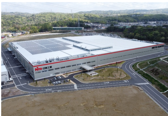
設置場所：日東工業株式会社 瀬戸工場
